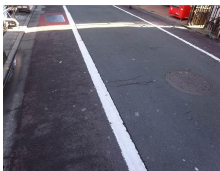
歩道のある例。白線が引かれているだけでも一応歩道です
